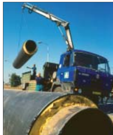
Předizolované potrubí umožňuje přímou pokládku do země bez nutnosti budovat kanály či kolektory.
