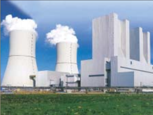
Nad elektrárnu nikdy nevychází žádný komín, kompaktní budova je celá obložená eloxovaným hliníkem se samočisticím účinkem
