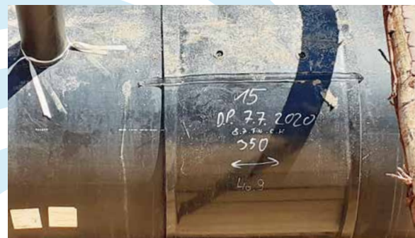
Dokončený spoj Mittel
