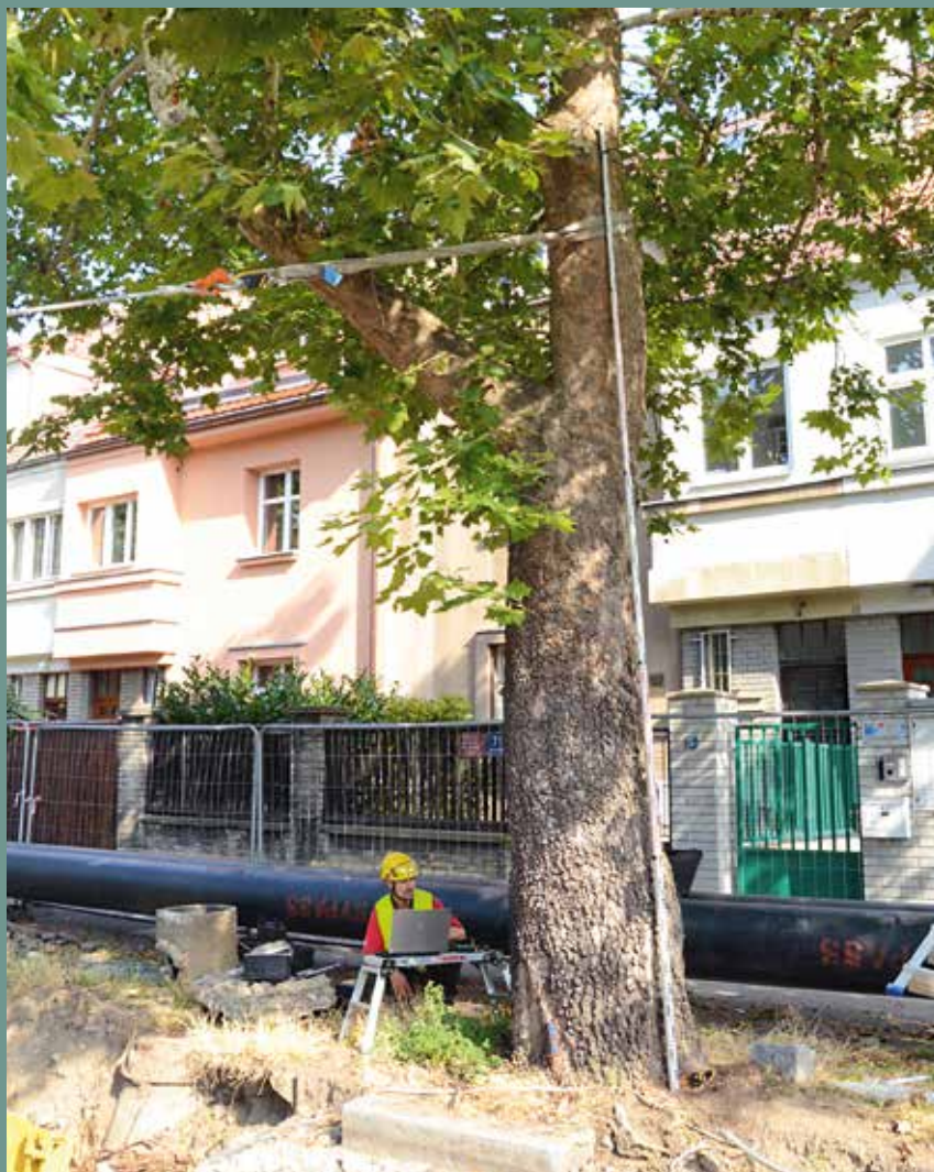
↑ Tahové zkoušky pro posouzení stability stromů před zahájením prací a po provedených pracích provádí pro Termontu společnost Arbonet.
