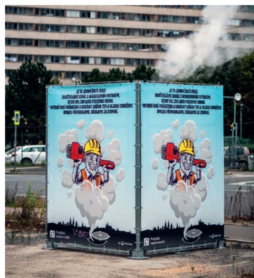
↑ Nedaleko podchodu pod Libuškou jsme umístili zástěnu, na níž ze země vystupuje džín stavebník. „Hlídá“ místo, kde se v chladném počasí vytváří mlhavý opar z podchodu s horkovodním potrubím.
