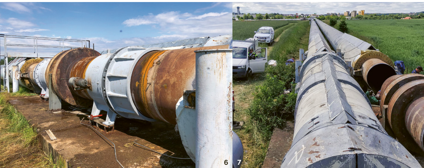
_____ 6. a 7. Během odstávek bylo vyměněno celkem osm kompenzátorů.
