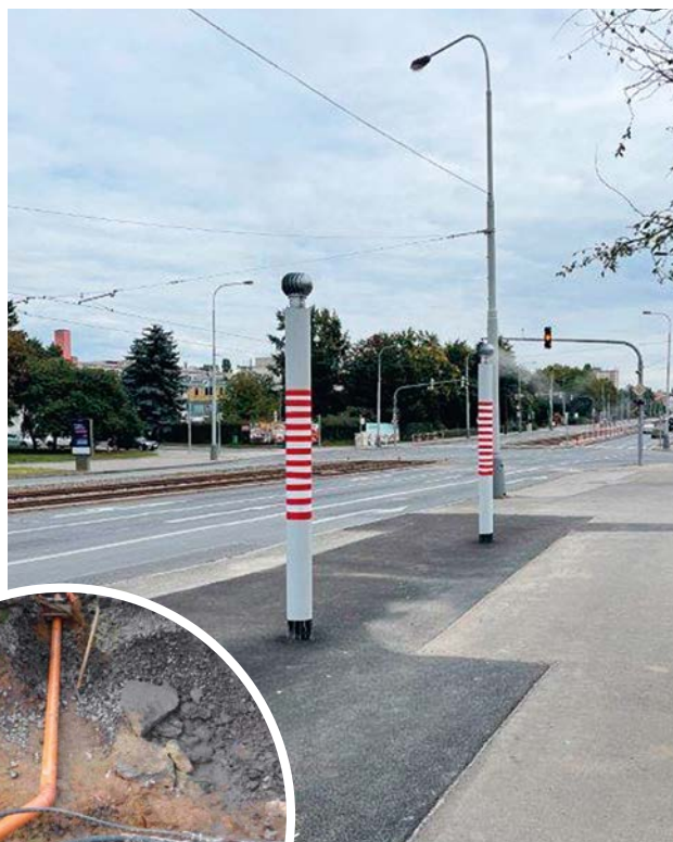
↑ Odsavače vodních par ve Švehlově ulici.
